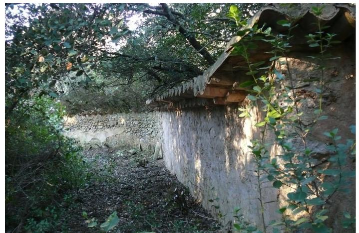
**Fig. 2.** Le rucher de Saint-James (Névian). Une banquette de 50 cm de large court tout le long de ce mur de 35 m de long qui pouvait abriter de 60 à 70 *bucs*. Une double génoise de 40 cm les protégeait de la pluie.
