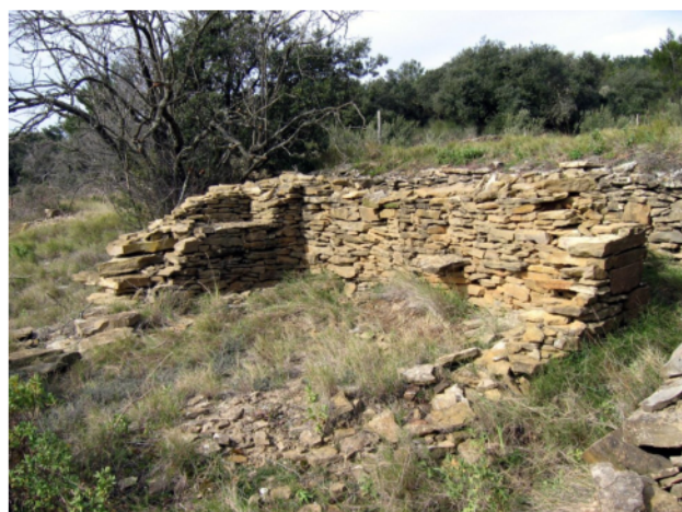
Fig.8. Deux abris à abeilles, à Tourouzelle. À gauche, l'abri des Moulats. On remarquera l'aménagement des deux murets d'une paire de mètres destinés à couper le vent dominant, en même temps qu'ils délimitent le domaine des abeilles, « lo seti » en occitan. A droite, le rucher du lieu-dit « Les abeilles ». Sans doute très ancien on en retrouve le nom dans la toponymie. Les ruches étaient abritées sous l'avancée du rocher, et un alignement de grosses pierres en délimitait l'emplacement.
