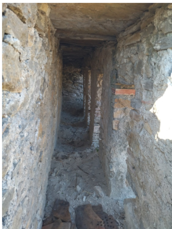
Fig.3. À l'entrée de la galerie se trouvaient les tessons d'une ruche en terre cuite.
