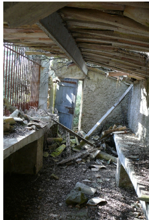
Fig.6. Rucher de Montrabech. Les ruches étaient posées sur l'étagère de gauche. Celle de droite recevait les ruches vides en attente d'utilisation et le matériel nécessaire aux diverses interventions. L'espace libre était largement suffisant pour travailler facilement.
