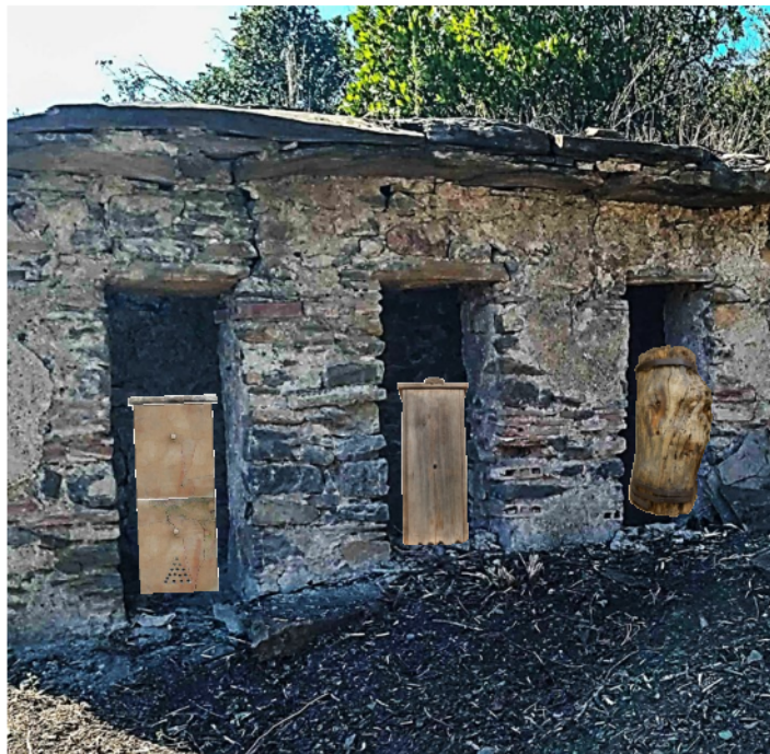
Fig.7. Armissan, Trialbe. Dimensions de la niche : 90 (H), 70 (l), 40 (P). On retirait le buc de son abri pour prélever la partie de récolte qui se trouvait au-dessus du croisillon. A droite, les embrasures ménagées dans le mur de Saint-Estève étaient beaucoup plus hautes que ce qui se pratiquait normalement pour le buc traditionnel en planches. Étaient-elles prévues pour des bucs plus lourds qu'on récoltait par le haut sans avoir à les déplacer ? Les ruches en terre cuite, lourdes et fragiles, entraient dans cette catégorie. De gauche à droite, la ruche en terre cuite, le buc traditionnel, le buc en tronc d'arbre.
