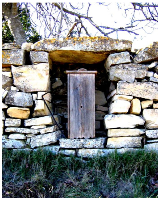
Fig.7. Armissan, Trialbe. Dimensions de la niche : 90 (H), 70 (l), 40 (P). On retirait le buc de son abri pour prélever la partie de récolte qui se trouvait au-dessus du croisillon. A droite, les embrasures ménagées dans le mur de Saint-Estève étaient beaucoup plus hautes que ce qui se pratiquait normalement pour le buc traditionnel en planches. Étaient-elles prévues pour des bucs plus lourds qu'on récoltait par le haut sans avoir à les déplacer ? Les ruches en terre cuite, lourdes et fragiles, entraient dans cette catégorie. De gauche à droite, la ruche en terre cuite, le buc traditionnel, le buc en tronc d'arbre.
